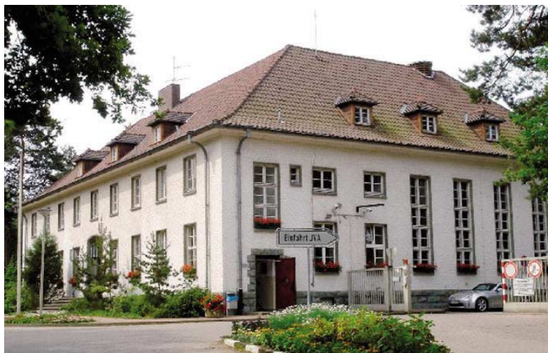
In der JVA Hövelhof ist die tägliche Vollzugspraxis durch Installation einer Personenschutzanlage erleichtert und die Sicherheit der Kolleginnen und Kollegen gleichzeitig erhöht worden.
