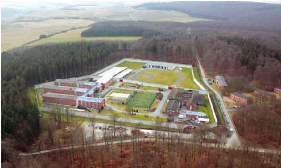
Nach umfangreichen Rückbaumaßnahmen soll die JVA Büren künftig als zentrale Abschiebehafteinrichtung genutzt werden.
